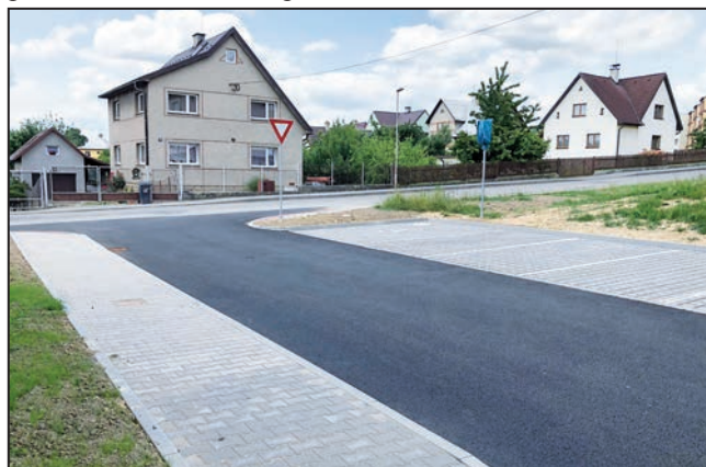
Nové parkoviště na Sídlišti 6. května u bytových domů č. p. 688 a 727
