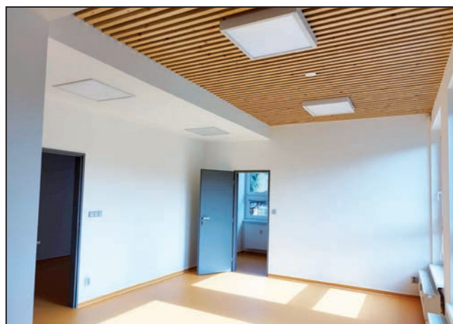
Prostory bývalé lékárny v „Dineru“ po rekonstrukci
