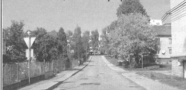
Vodovod a chodník, ulice Sídlištní po opravě
