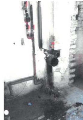
Původní místo po odpojení kotle
