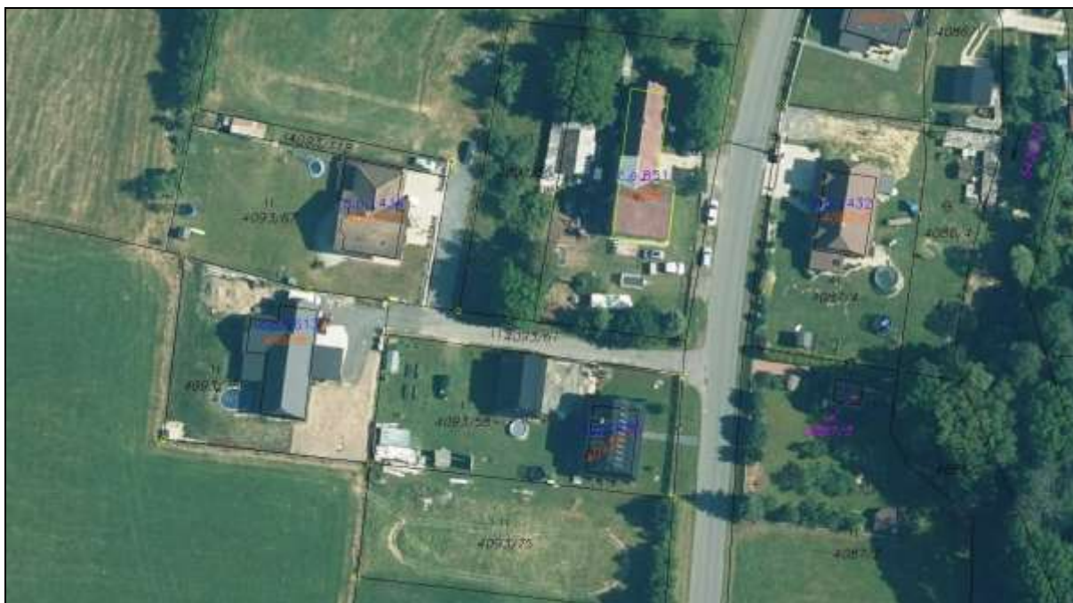
Lokalita „za Hájenkou“ ve Starém Zubří – vodovod, kanalizace a příjezdová komunikace se nacházejí na pozemku parc. č. 4093/61 v k. ú. Zubří
